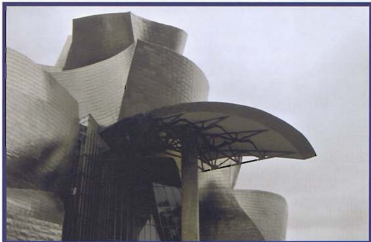
• Le strutture del museo Guggenheim (foto di A. Zappa)
