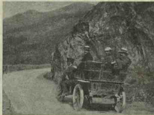
Sulla strada di Ceres: sotto Sant' Ignazio. (Fot. Wehrheim).
