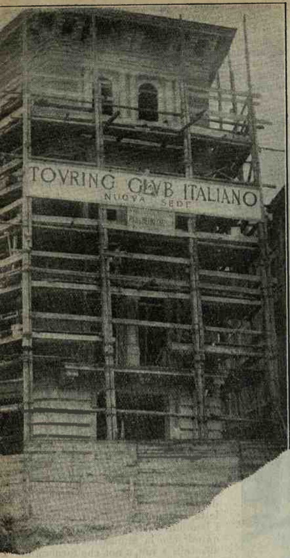
Lo stato dei lavori alla metà di Novembre.
