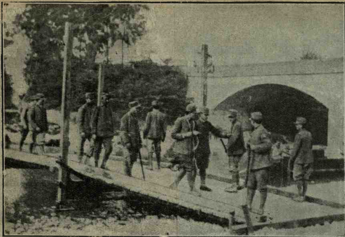
La nostra guerra. — La costruzione di un ponte per il passaggio delle nostre truppe nelle terre da noi conquistate. (Fot. Strazza - lastre Cappelli)
