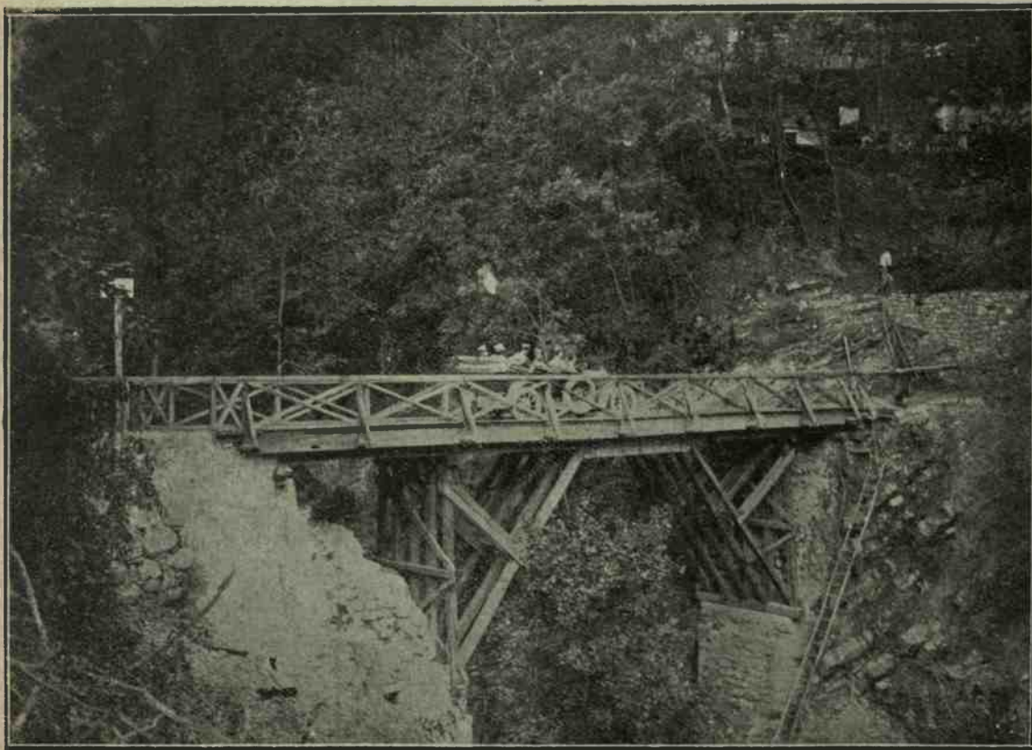
Ponte costruito dal Genio militare sull'alto Isonzo. (Comando Supremo - Reparto fotografico).
