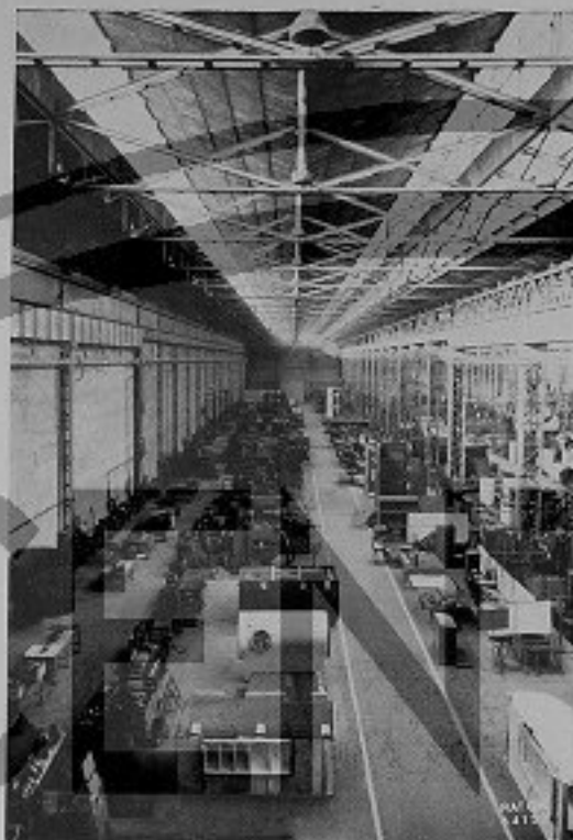
Fig. 6 - Linea di lavorazione lamiera sottile (fino a 8 mm)
