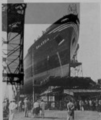
In copertina: La M.n. "Galassia", da 35.000 bwh, costruita per conto della Italsider e dotata di motore FIAT tipo 908 S, pronta per il varo nel Cantiere Ansaldo - Mug- liano (La Spezia).
