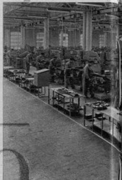
Pur nella vastità, questa veduta presenta quell'importante attrezzatura che occupa, sono in funzione, altre 150 stanno per
